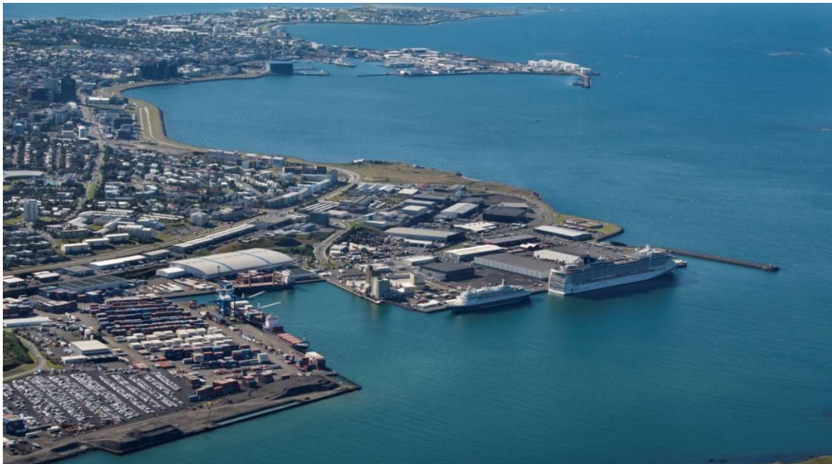
MYND 3.2 Yfirlit yfir hluta framkvæmdasvæðisins. Stærsta landfyllingin verður að fylla upp í innskotið fyrir miðri mynd. Á myndinni er unnið að gerð Sundabakka sem nú er lokið.
